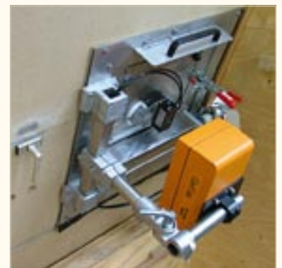
FMV in Fallschacht unter Trocknerzyklon
