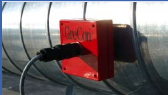
Sensor de faísca instalado
