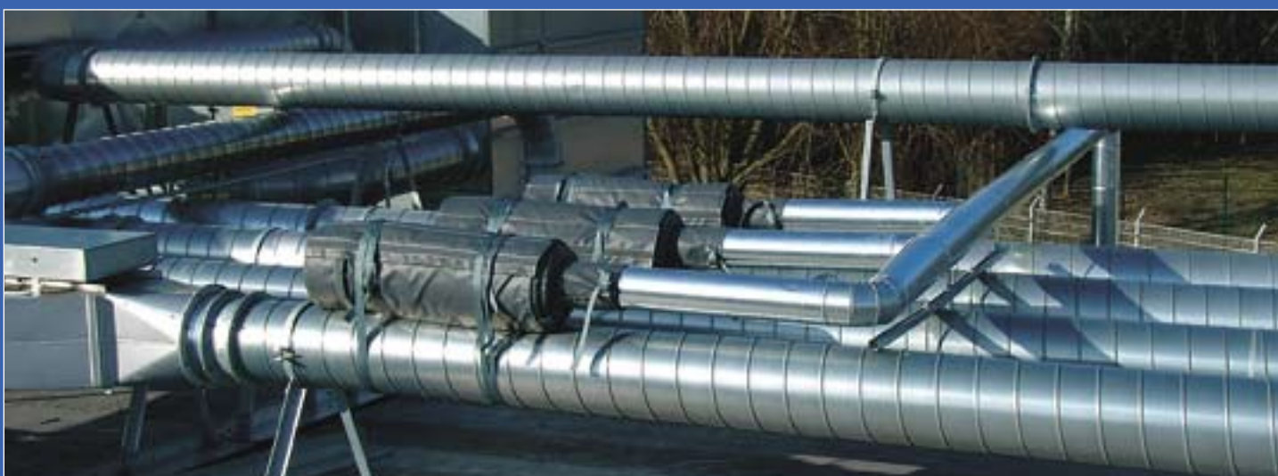
Proteção anticongelamento com sacos isolantes
