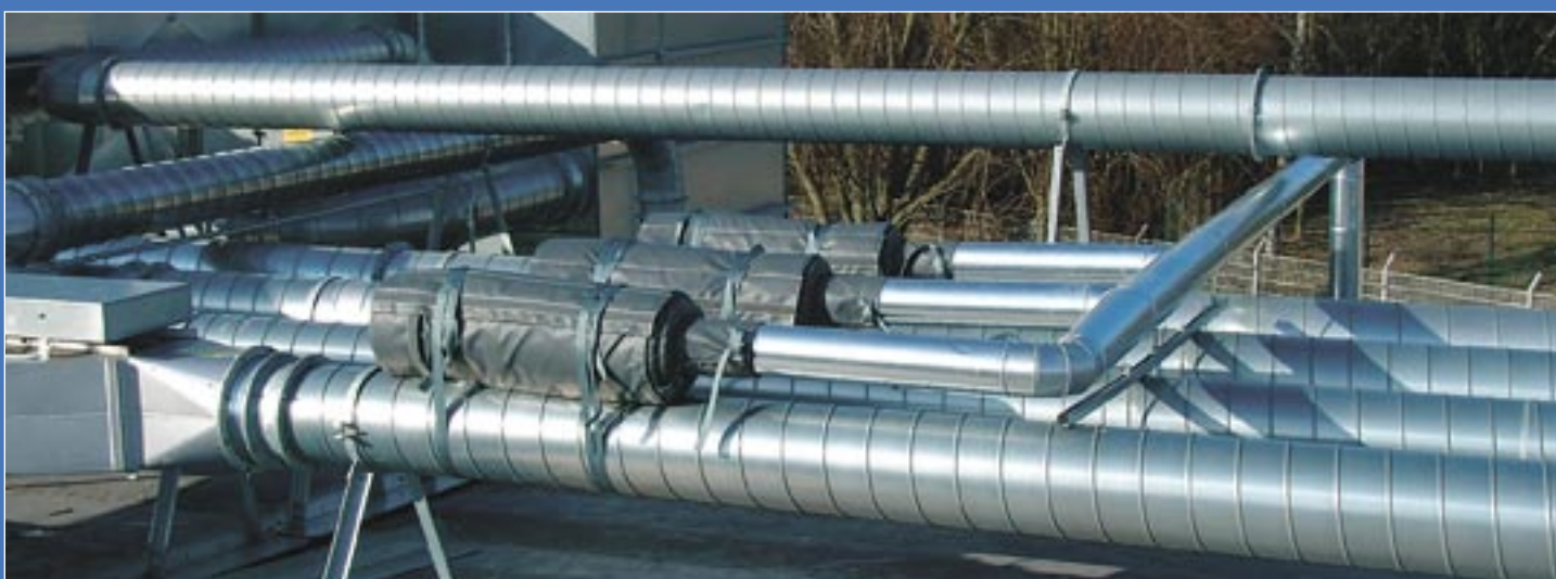
Frostskydd med isoleringshuvar
