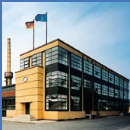
Továrna Fagus, postavena Waltrem Gropiusem v roce 1911
