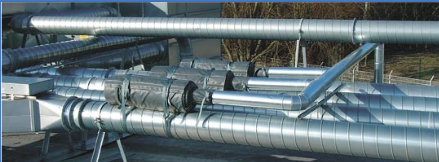
Protection contre le gel avec sacs isolants
