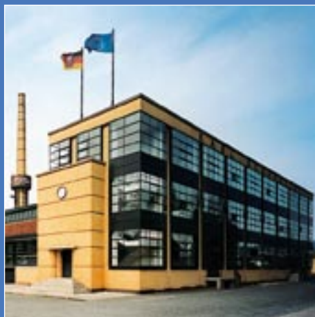
L'usine Fagus, construite en 1911 par Walter Gropius
