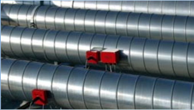
Entstaubungsanlage mit Funkenmeldern
