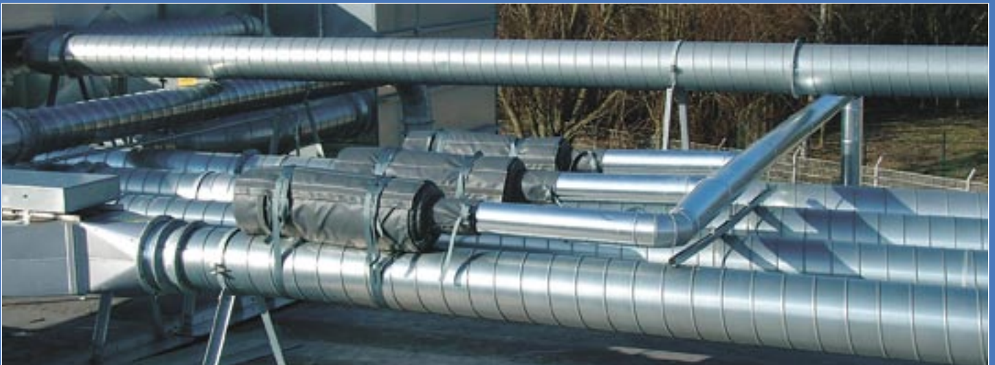
Frostschutz für Löschautomatik mit Isoliertaschen
