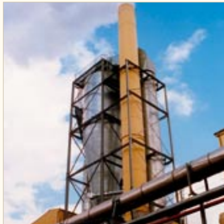
Siklon gözetim tesisi ABC 7
