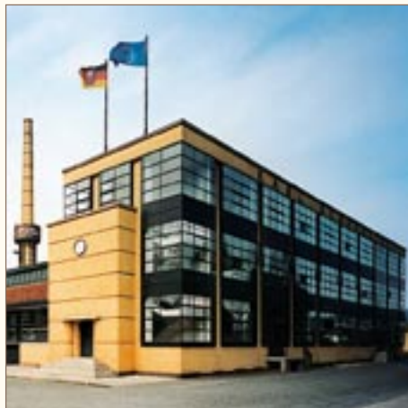
L'usine Fagus, construite en 1911 par Walter Gropius
